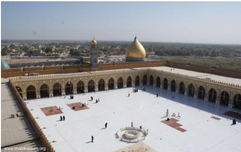
مسجد کوفه پس از بازسازی بهره‌ها
